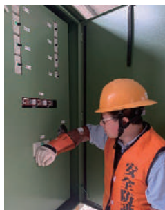
太陽能設備的斷電操作程序演練
