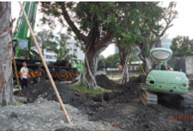
嚴密移植計劃保留樹冠完整性，確保喬木移植後繼續正常生長，照片為喬木移植後
