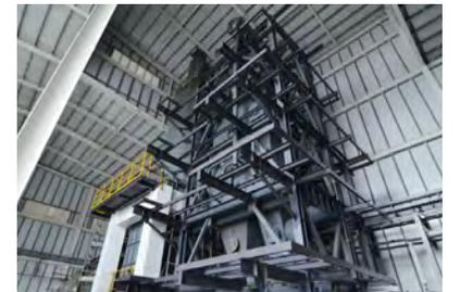
鍋爐完工後，規劃可焚化處理 7,280 公噸之廢棄物，包含廢塑膠與有機性汙泥，焚化所產生之熱能可取代原天然氣燃料用量，預估可避免採用天然氣之碳排放 1,547tCO<sub>2</sub>e/ 年。
